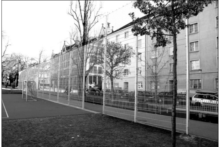
Neuer Ballfang Dreirosenanlage
