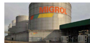
Das Migrol-Tanklager, Uferstrasse
