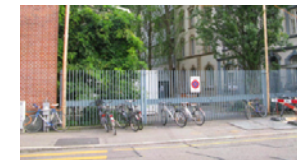
Tor an der Schönaustrasse
