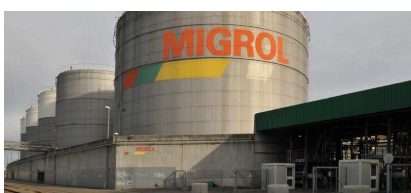
Das Migrol-Tanklager, Uferstrasse
